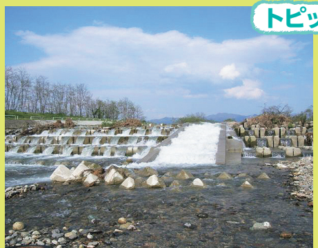
▶立谷川に整備した魚道
